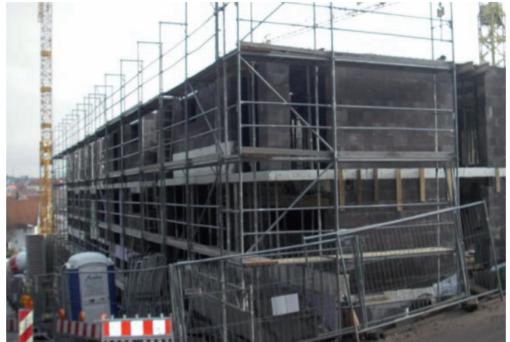
▲ Rohbauarbeiten Haus A / B / C
