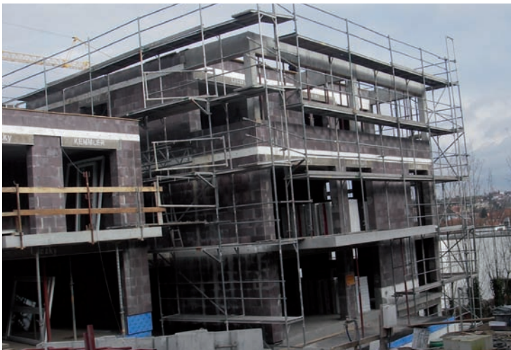
▲ Rohbaufertigstellung Stadtvilla D und Reihenhäuser E
