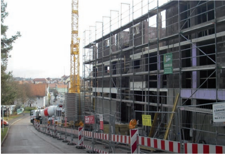
▲ Rohbauarbeiten Haus A / B / C
