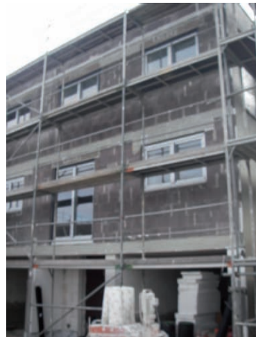
▼ Fenstereinbau Reihenhäuser G
