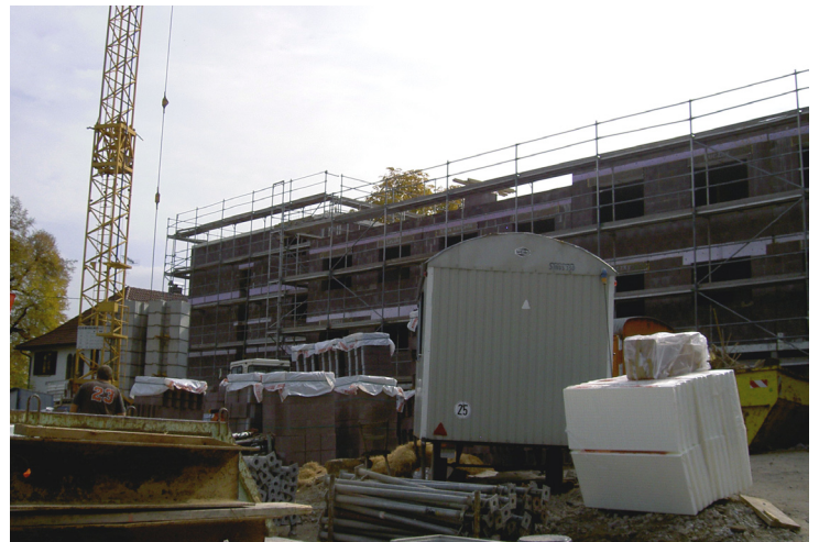
▼ Rohbauarbeiten Stadtvilla F und Reihenhäuser G
