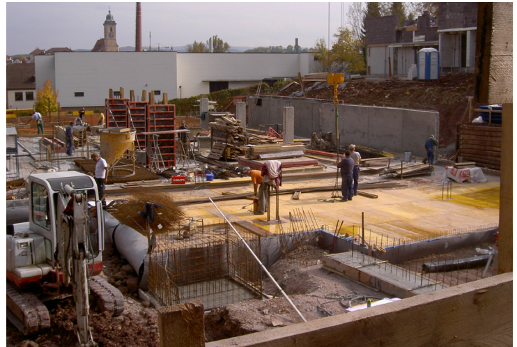
▲ Herstellen der Tiefgarage Haus B/C
