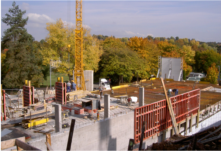
▲ Herstellen der Tiefgarage Haus A
