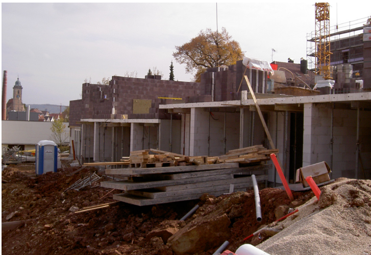
▲ Rohbauarbeiten Stadtvilla D und Reihenhäuser E
