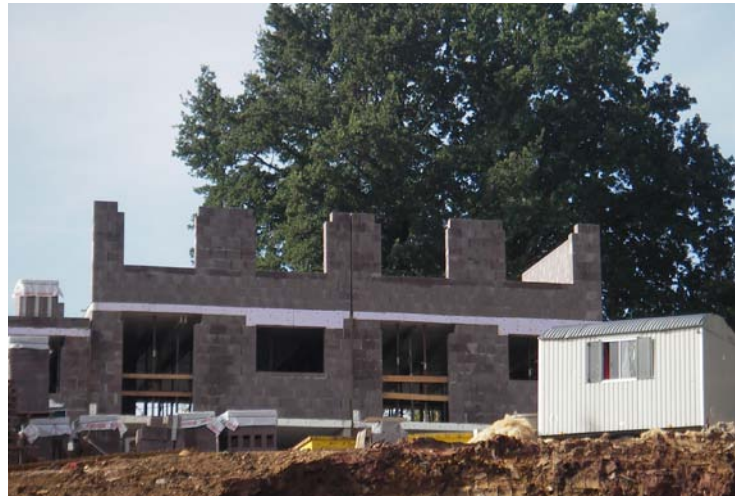
▲ Rohbauarbeiten Reihenhäuser G
