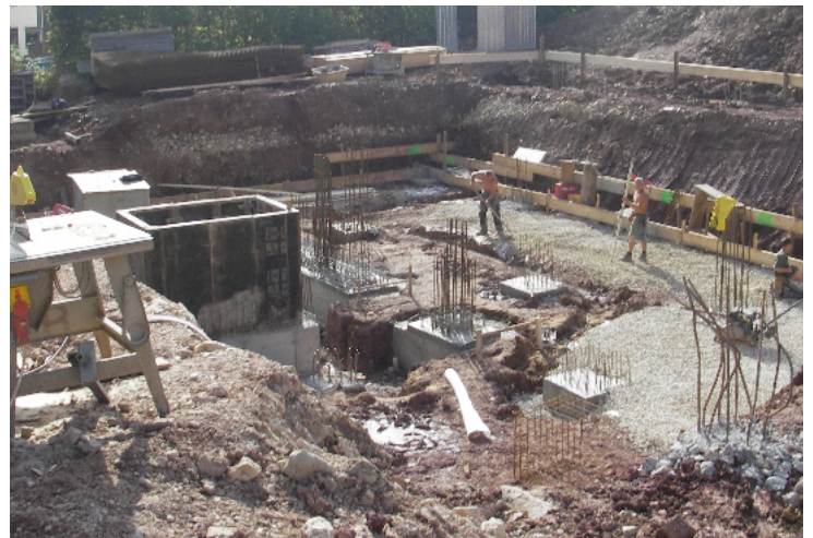
▼ Fundamentgründung Haus A
