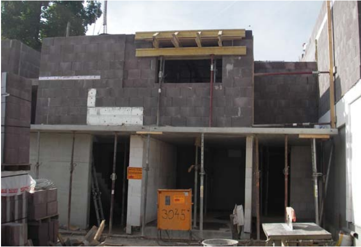
▲ Rohbauarbeiten Stadtvilla F
