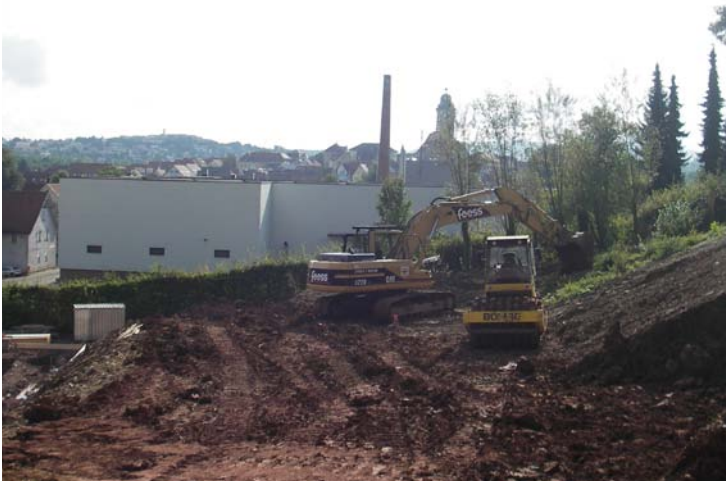
▲ Erdarbeiten Stadtvilla D und Reihenhäuser E
