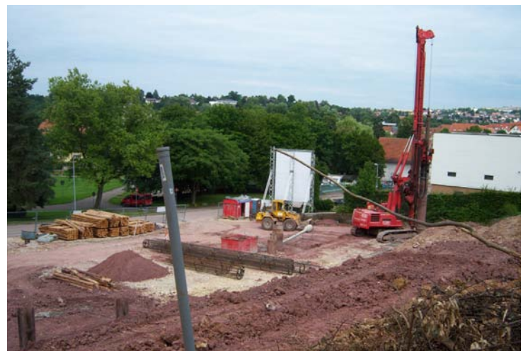
▼ Bohrpfehlgründung Haus A
