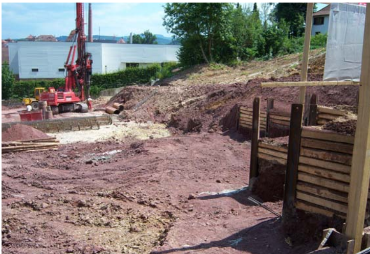
▲ Verbaumaßnahmen Haus B und C
